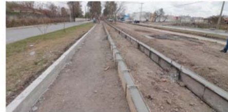
Para seguir ampliando la infraestructura dedicada a la recreación familiar y a la práctica del deporte este lunes el Presidente Municipal de Matamoros activó los trabajos para la construcción de una ciclovia y una vitapista en el Parque Lineal Cantinflas, acciones en las que se aplicará una inversión superior a los 2 millones 800 mil pesos.
