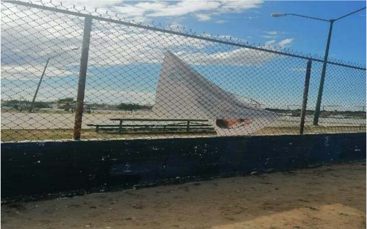
Una lona (No. 3), por la calle técnicos, dicha lona se encuentra doblada
