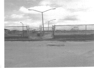
Muro color azul con placa dentro de la plaza cívica Fovissste- Solidaridad, puerta de acceso principal cerrada.
